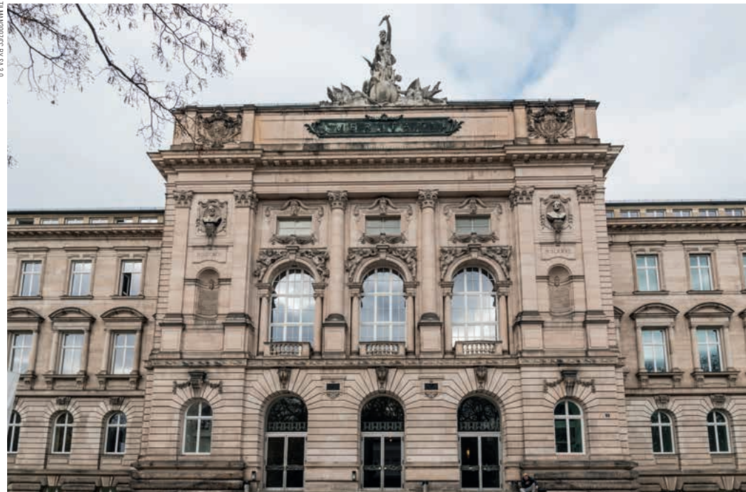
Hauptgebäude der Julius-Maximilians-Universität am Sanderring
